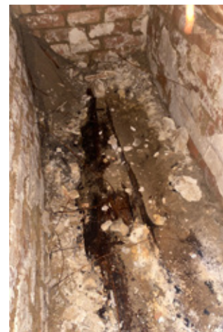
Graben für Wasser- und Abwasserleitungen mit gemauerter Gruft.
