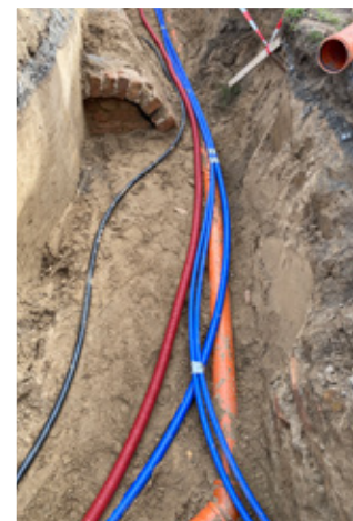
Im Graben verlegte Leitungen für die Anschlüsse der Alten Dorfkirche.
